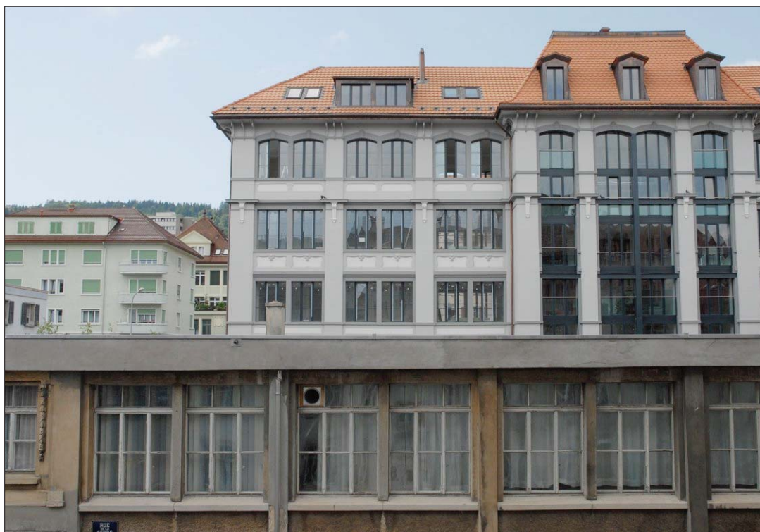
LA CHAUX-DE-FONDS A l'ouest de la ville, un exemple de mixité entre une vieille usine en activité et une ancienne transformée en loft insérées dans un quartier d'habitations.
